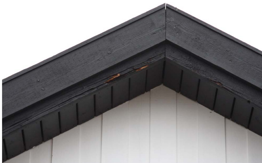
Stern- og dækbrædder under nedbrydning
