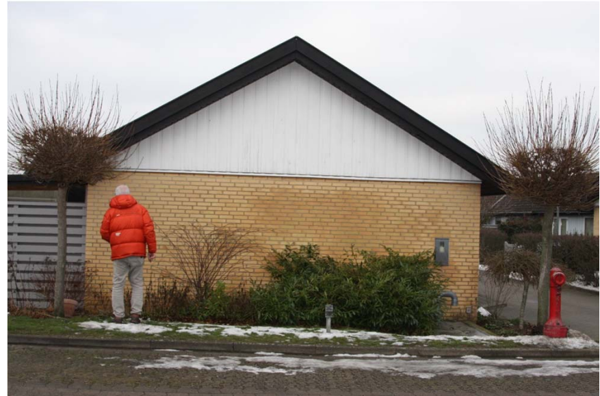
Muret gavl med træbeklædt på taggavl
