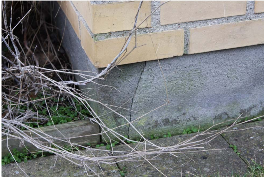
Revnet sokkelhjørne
