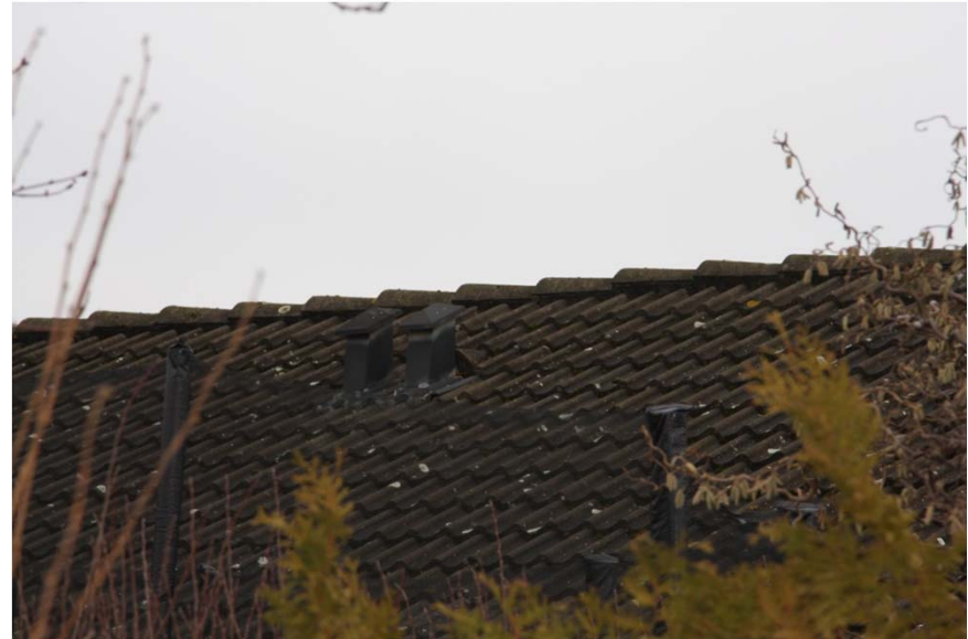
Tagflader med betontagsten
