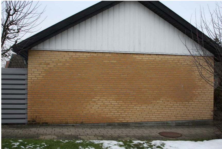
Opfugtet muret gavl (Sandsynligvis efter regnvejr)
