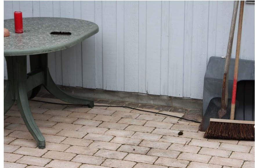
Pudset sokkel under nedbrydning
