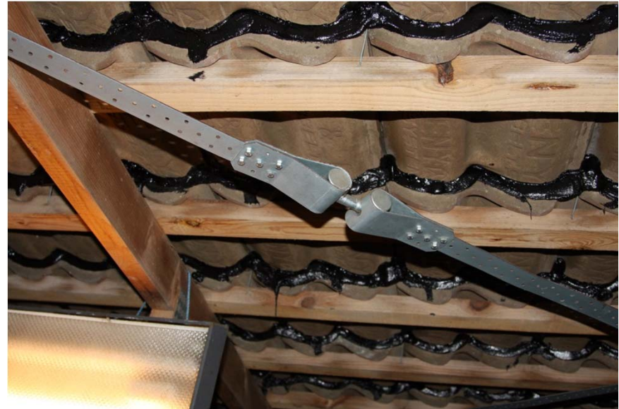
Stabiliserende stålkonstruktion
