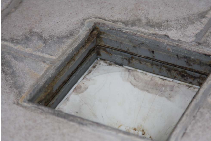
Gulvafløb i flisegulv
