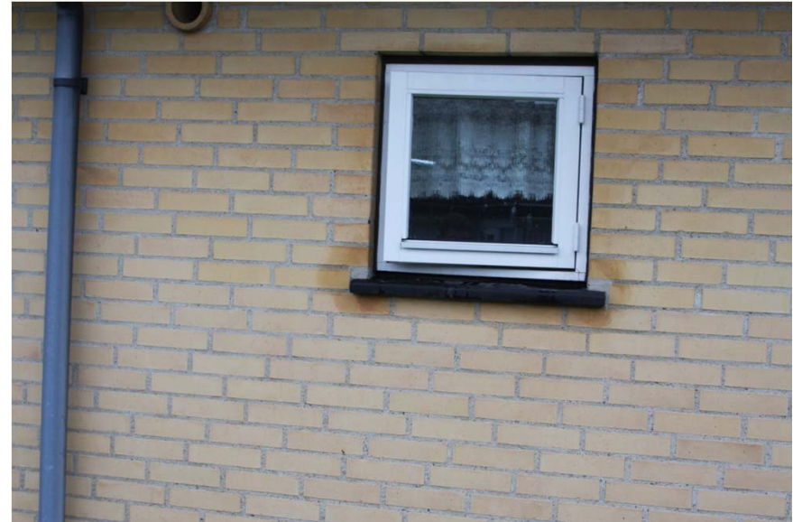
Trævindue i muret facade
