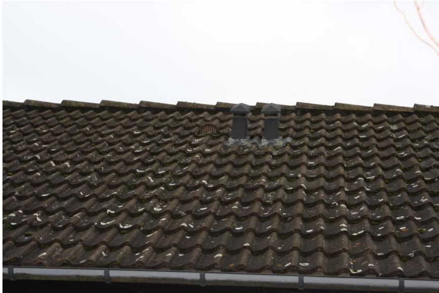
Tagflader med betontagsten
