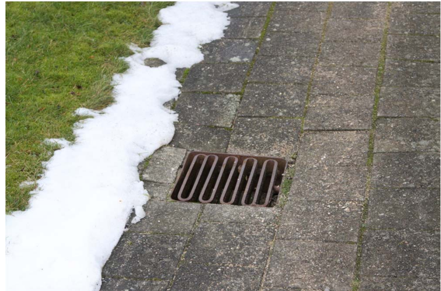
Overfladeafvanding i fliseareal
