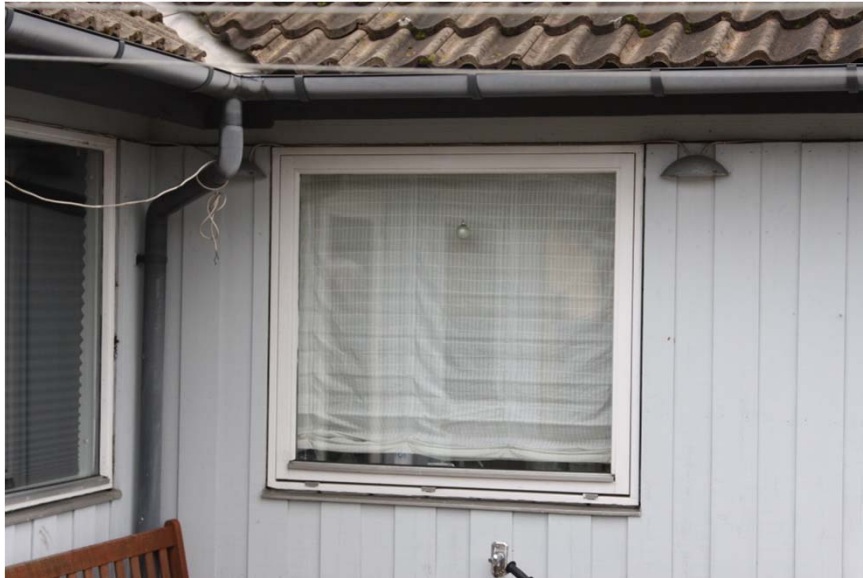
Vinduespartier i let træfacade
