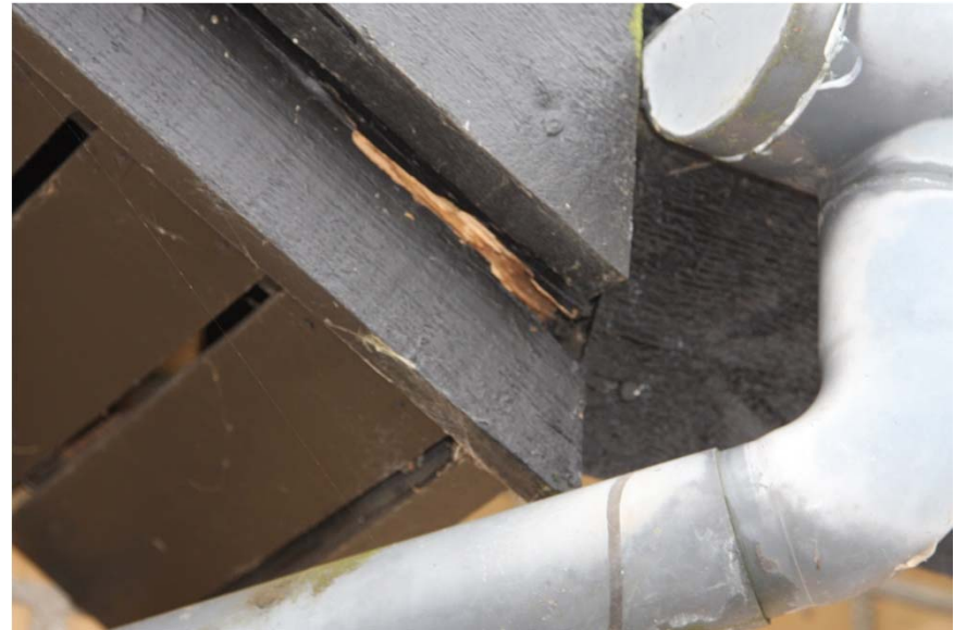
Sternbræt under nedbrydning
